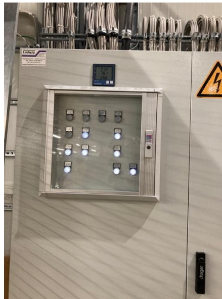
22 - Zentrale Steuerung der Beleuchtung
