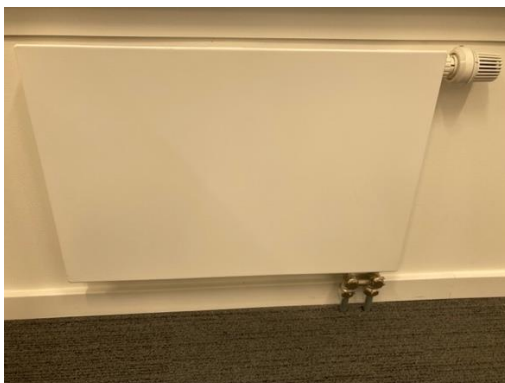
35 - Heizkörper mit herkömmlichen Thermostaten
