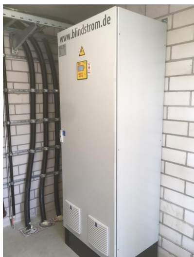
10 Blindstromkompensationsanlage
