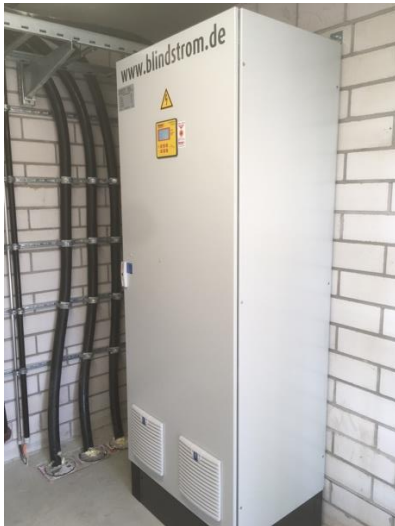
10 Blindstromkompensationsanlage
